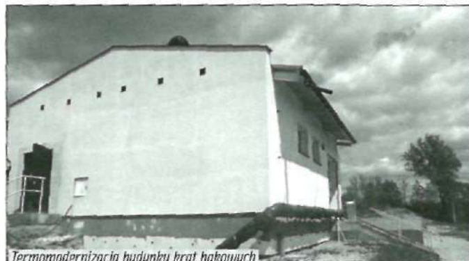
Termomodernizacja budynku krat hakowych
