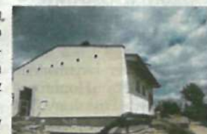
Termomodernizacja budynku krat hakowych.
