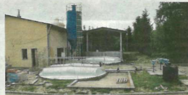
Termomodernizacja budynku krat hakowych.
